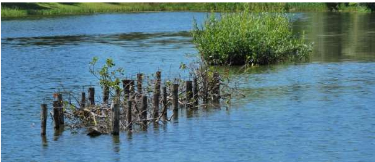
Figuur 5.2 Een dubbele palenrij met daartussen grof snoeihout, een goede schuilplaats voor jonge vis.
